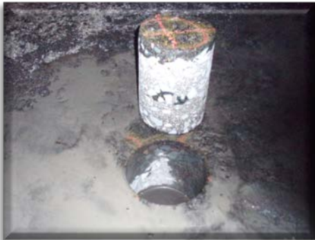
Încercări realizate pe structura pistei de zbor a aeroportului din Iași
