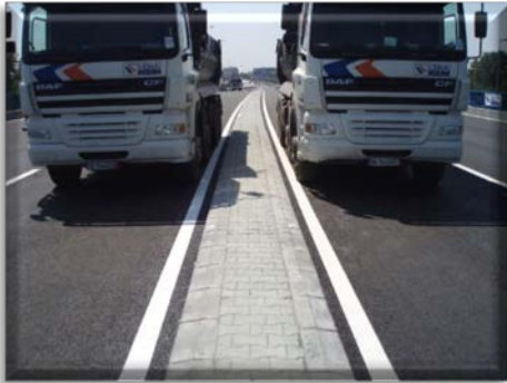
Încercări statice realizate la un pod rutier aflat pe drumul național DN1 București – Ploiești
